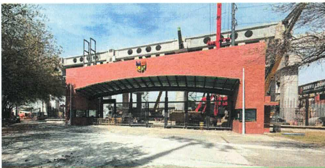
Rehabilitación de accesos
