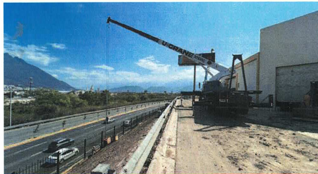
Talud Av. Constitución
