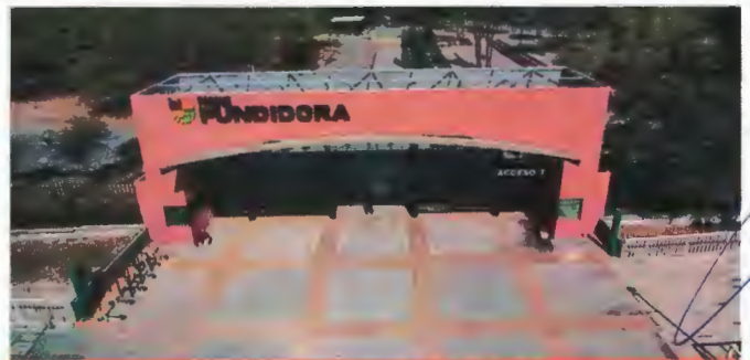
Rehabilitación de accesos
