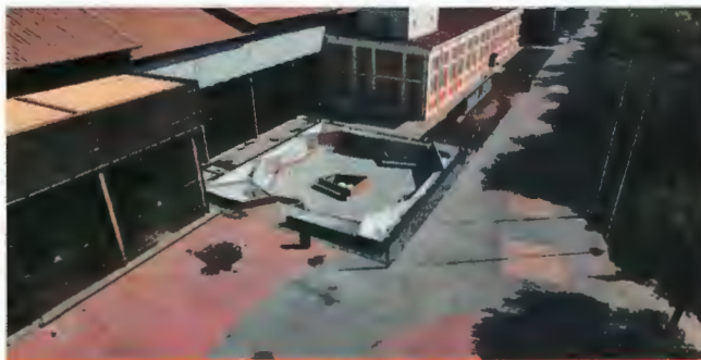
Exterior Nave Lewis
